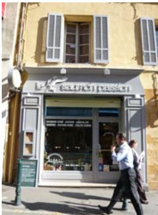
Les devantures en applique de type façades menuisées (coffres bois) ne doivent pas masquer **les éléments de modénature** de la façade : chaîne d'angle, encadrements de baie, cordons...
