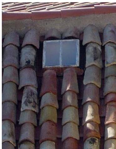
Exemple et croquis de fenêtre de toit placée dans le plan de la toiture sans surépaisseur, menuiseries métalliques composées de fers en T de faible section
