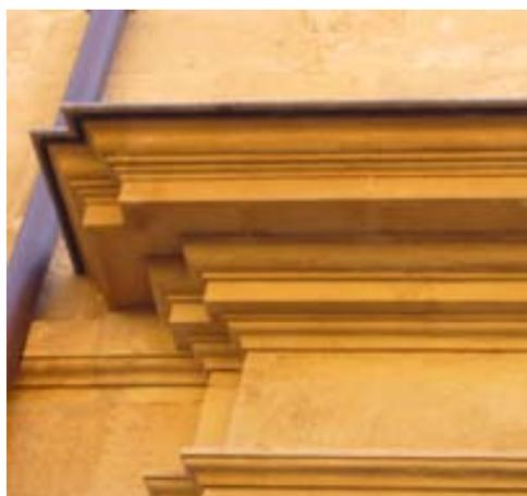
**Bavettes ou couvertines :** protection des éléments de façade saillants, corniches, cordons, entablements, chapiteaux, frontons,... par des bavettes ou couvertines en zinc ou plomb, après restauration des épaufures au mortier ou remplacement de pierre
