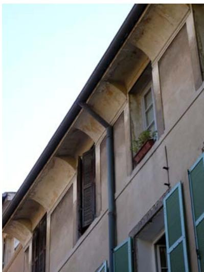
Exemple et croquis de principe : fenêtre d'étage sous toiture disposée dans la corniche aixoise
