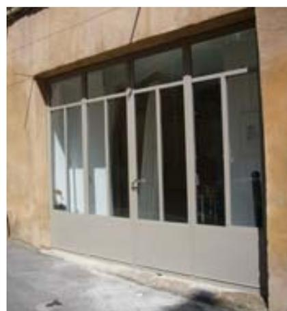
Menuiseries de section fine placées en tableau ou en feuillure intérieure, retrait d'environ 20cm par rapport au nu de la façade, menuiseries bois ou acier.
