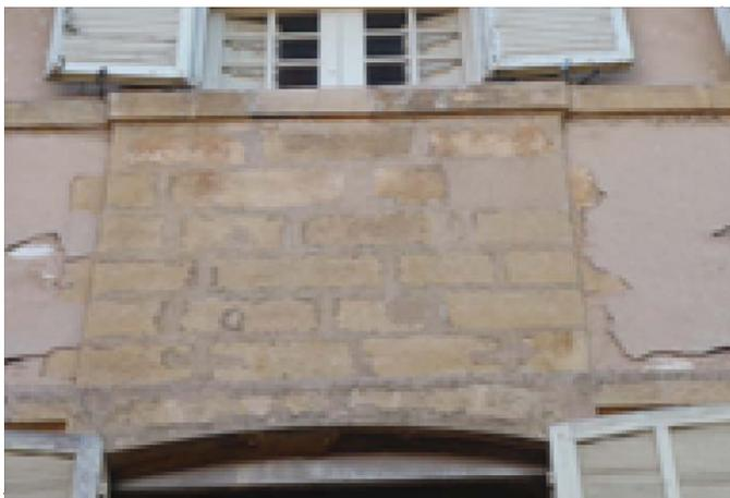
**Joints repris au ciment, traitement à prévoir :** Purge des joints ciment et reprise au mortier de chaux de teinte et de grain similaire à la pierre en place. Les joints ne doivent pas être élargis à l'occasion de leur réfection.
