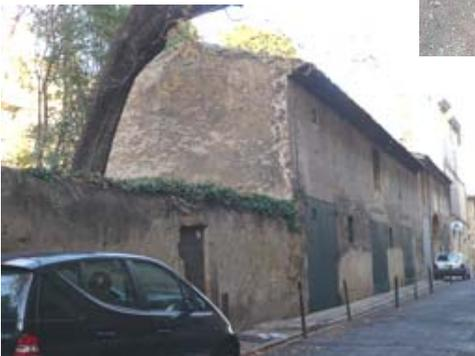
Enduit en place à identifier et à restituer avant restauration ou décroûtage. Les **enduits traditionnels à la chaux** sont plus adaptés à la nature des maçonneries en moellons de pierre. Les **façades pignon** reçoivent le plus souvent un simple enduit à la chaux teinté par le sable.
