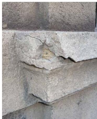
**Epaufures, traitement à prévoir :** purge des reprises ciment, reprise au mortier de chaux (**ragréage**), de nature, porosité, dureté et teinte, similaire à la pierre.
